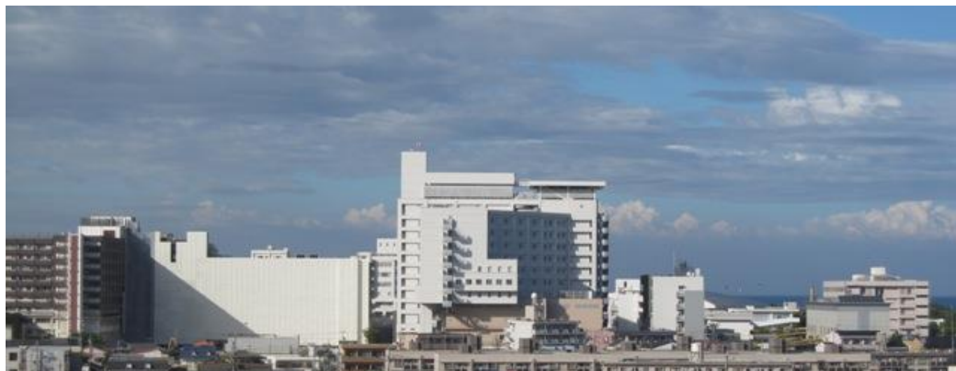
三重大学医学部 旧病院（左端）、外来棟（建設中、白い部分）新病院（中央）、看護学科棟（右端）：県津庁舎より 2013
